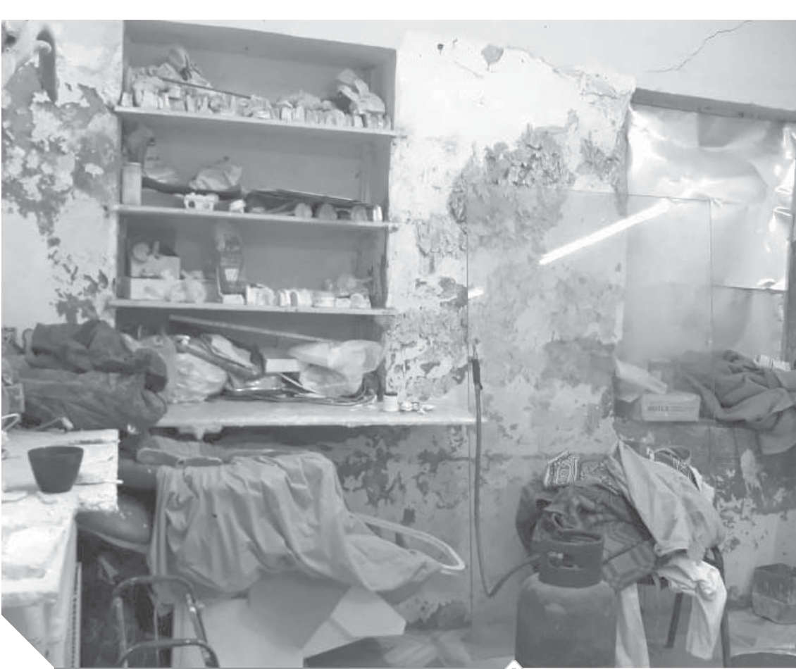
أحد المعامل تأكلت جدرانها بفعل تسرب المياه إلى حوائطه
