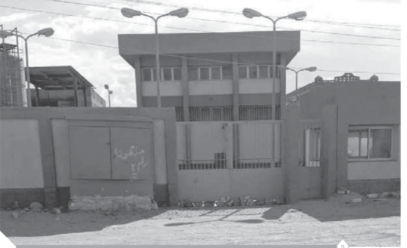
محطة الصرف الصحي فى قرى البدرشين
