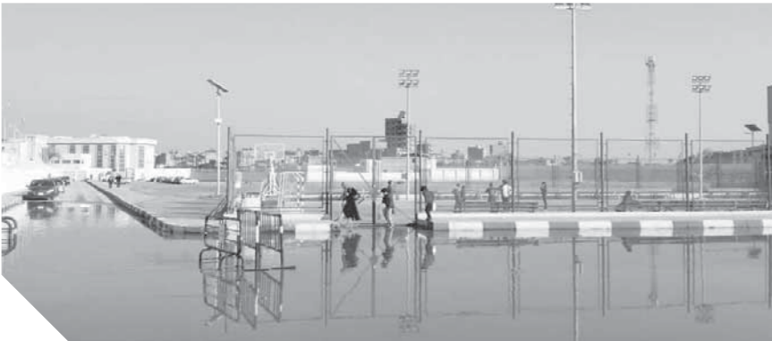
نادى قارون غارق فى مياه الصرف الصحى
