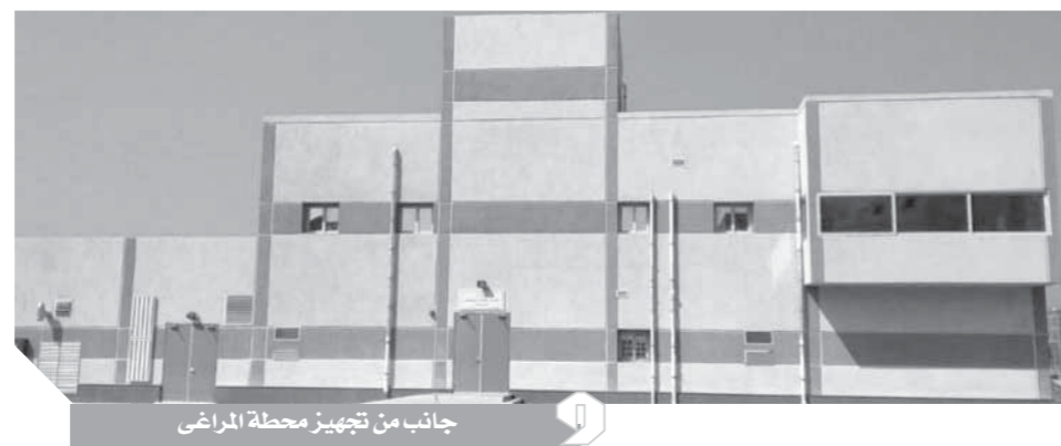
جانب من تجهيز محطة المراضى
