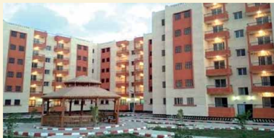
المناطق. وأضاف المهندس أحمد عمران: جار تنفيذ 8 مشروعات طرق بالمدينة، وتشمل مشروع تطوير المحور الرئيسي من التفق حتى ميدان عربا، بتكلفة 39.14 مليون جنيه، وبلغت نسبة التنفيذ 62%. ومشروع تطوير خط
