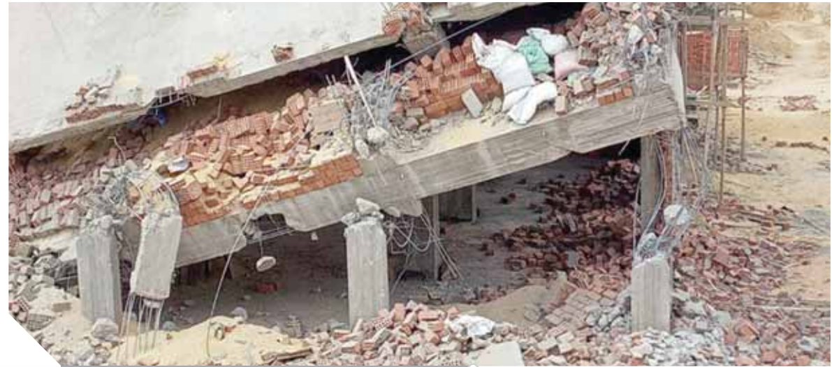
بلمدورز الحكومة مستمر في هدم المباني المخالفة
