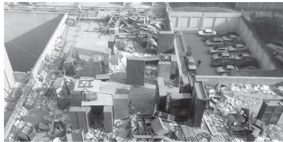
سطح أحد المنازل قبل تحويله لمساحة خضراء
