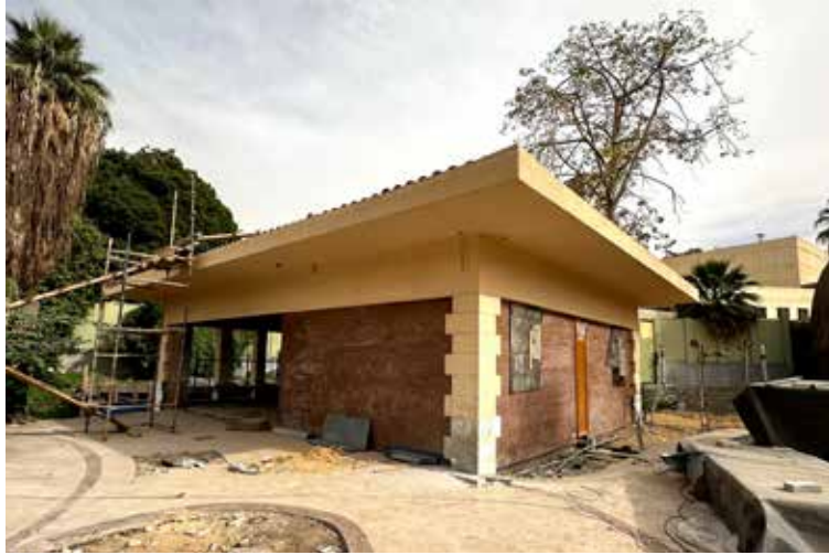
إنهاء أعمال القرميد للأسطح
