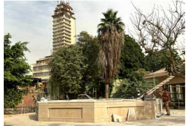
أعمال التشطيب ارضيه للبرجولة A
