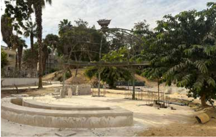
جاري أعمال تركيب رخام أرضية بلازا التاج الملكي
