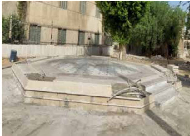
أعمال التشطيب ارضيه للبرجولة D
