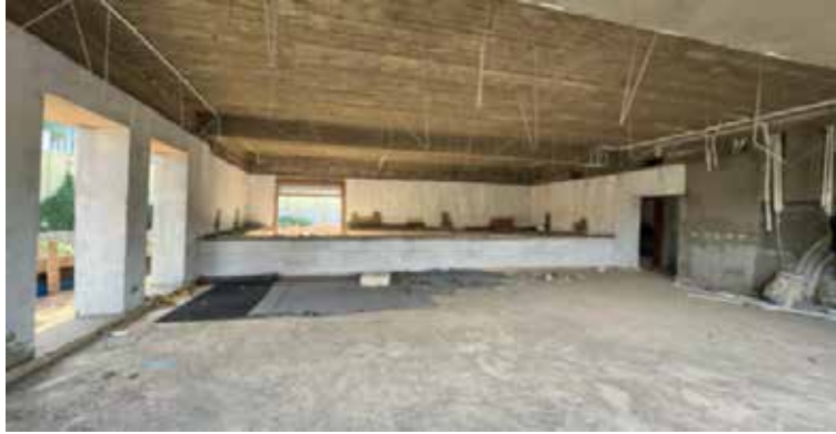
جاري أعمال تأسيس السقف المعلق
