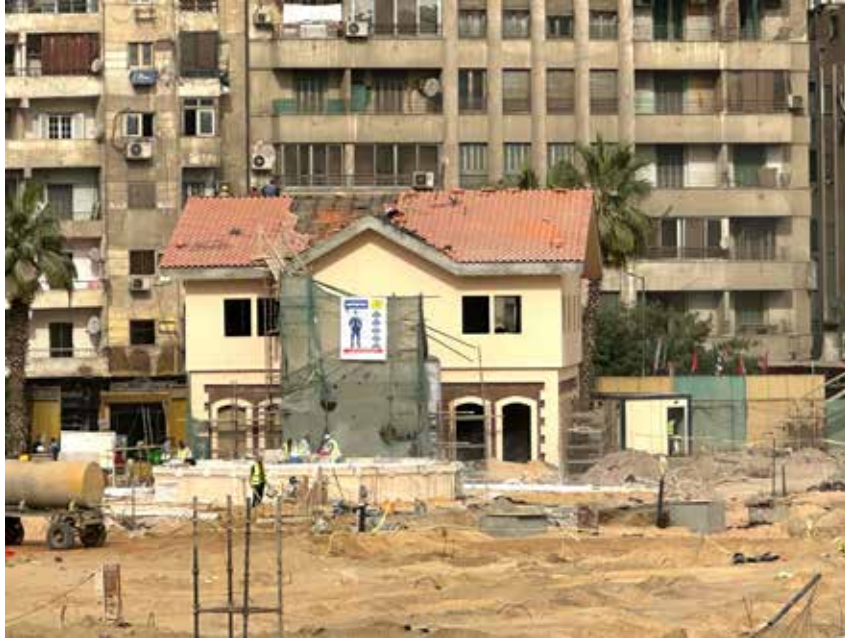
جاري أعمال عزل سقف الدور الأول جاري أعمال تأسيس الصفي في الدور الأرضي
